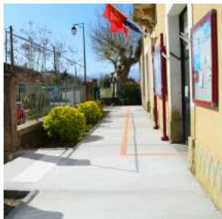
Accès « Personne à Mobilité Réduite » de la mairie
