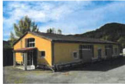
Salle d'animation rénovée.
