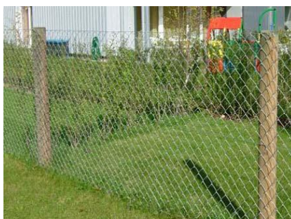
Clôture grillagée et poteaux en bois
